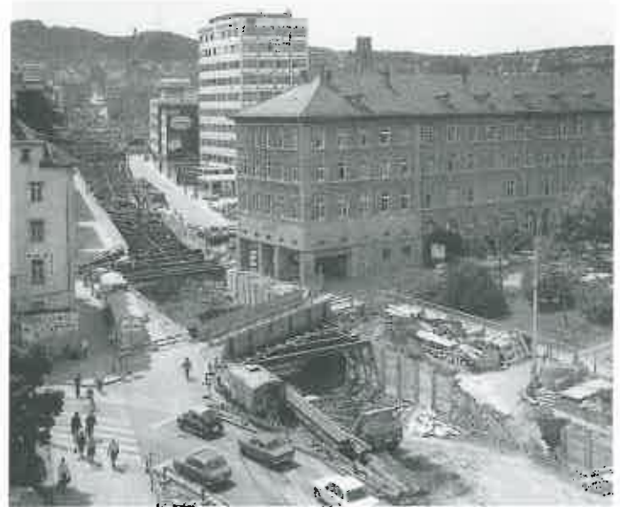
Eine Großbaustelle dieser Art würde das Zentrum jahrelang belasten.
